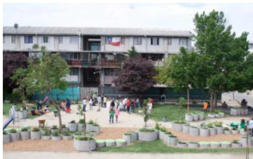
De arriba hacia abajo y de izquierda a derecha: 1) Plaza Villa San Luís en Renca antes de la intervención, 2) Plaza Villa San Luís al iniciar el día de la construcción 3) Plaza Villa San Luís terminada 4) Plaza Mayor Villa Javiera Carrera Maipú después de la intervención.
